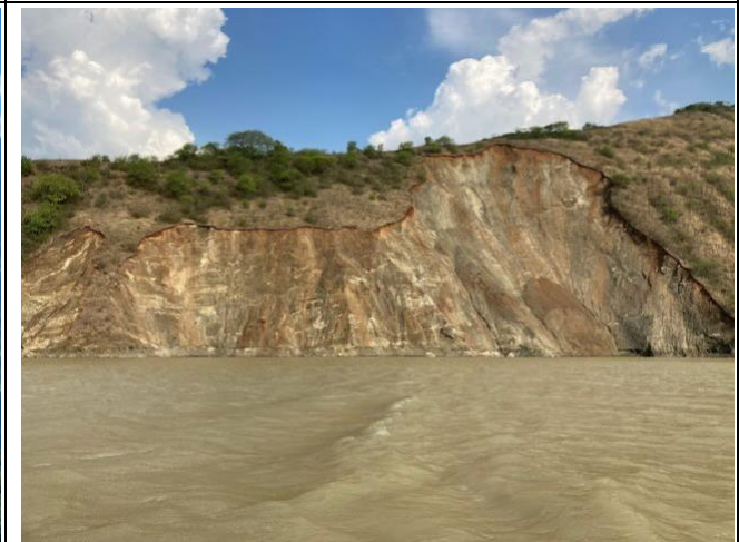
Foto 6: Talud inestable en el embalse 1
