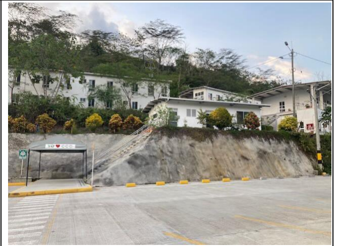
Foto 57: Oficinas del campamento del contratista principal CCC
