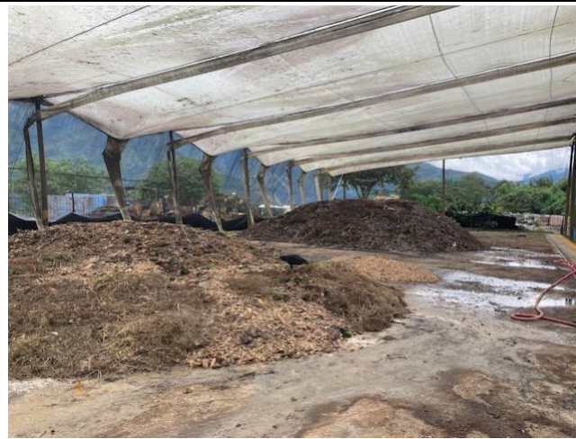
Foto 65: Instalación de compostaje en el campamento CCC
