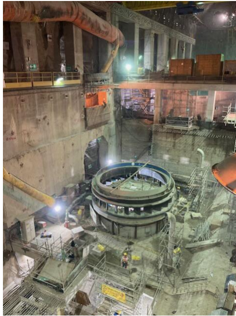
Foto 76: Montaje de unidades de generación
