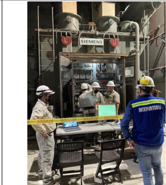
Foto 69: Trabajos de montaje en caverna de transformadores
