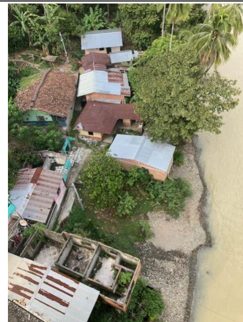
Foto 93: Viviendas en Puerto Valdivia afectadas por inundación durante contingencia
