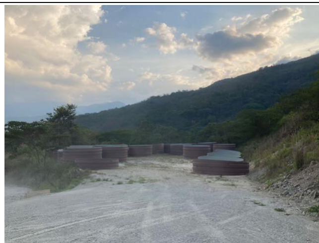
Foto 44: Almacenamiento de virolas para reparar tramos de toma dañados por la contingencia, en margen izquierda
