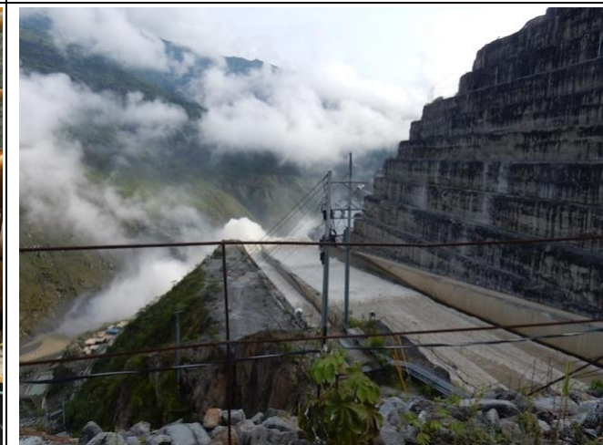
Foto 42: Vertedero desde la cresta de la presa
