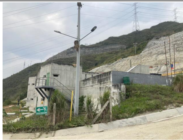
Foto 35: Puesto militar sobre la presa
