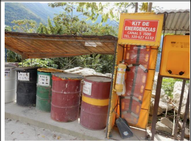
Foto 18: Gestión de residuos en obra de estabilización de taludes 0+900
