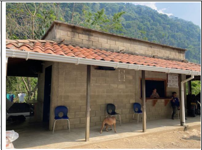
Foto 87: Inversión comunitaria de EPM en carretera a Puerto Valdivia aguas abajo, construida por el proyecto Ituango
