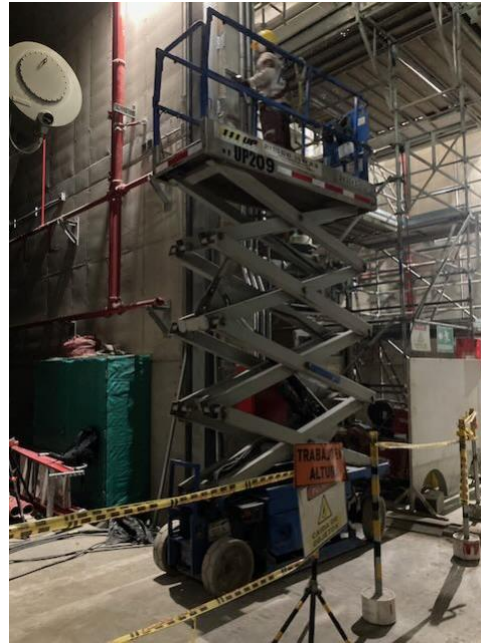
Foto 77: Trabajo en alturas
