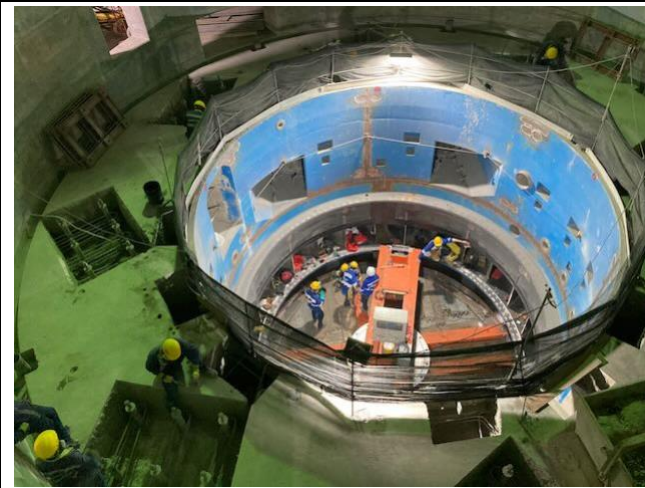
Foto 71: Montaje de unidades de generación
