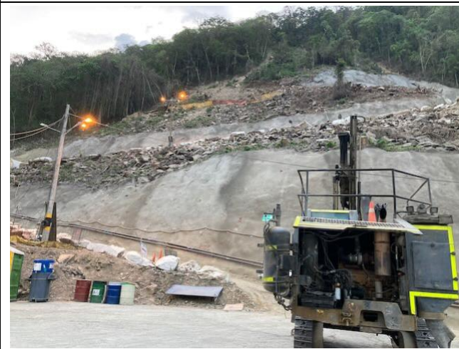
Foto 17: Estabilización de taludes a 0+900
