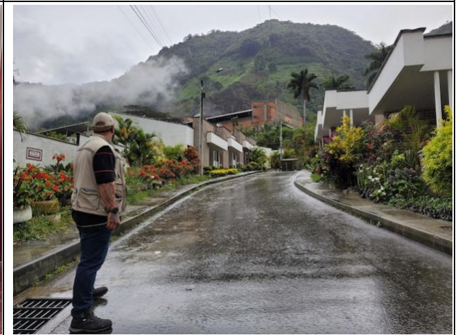
Foto 108: Comunidad reasentada Jardines de San Andrés, para familias afectadas por la vía alrededor del municipio de San Andrés, construida para reducir los impactos del tráfico desde la vía principal de acceso al proyecto
