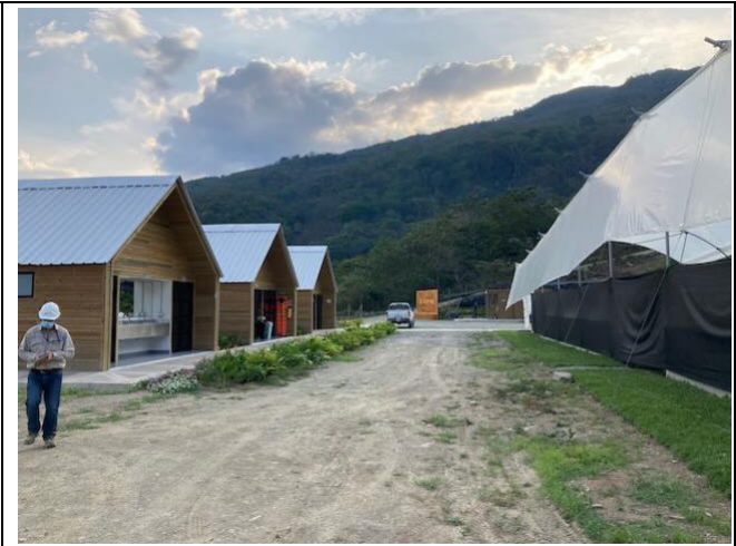
Foto 27: Zona de crecimiento El Palmar con edificios de personal
