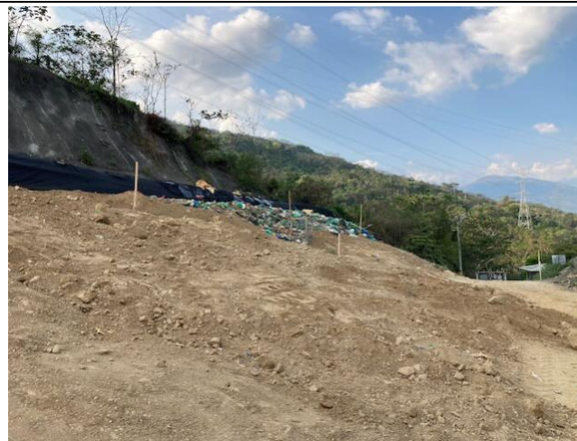
Foto 29: Proyecto zona de disposición en proceso de cierre y cubrimiento
