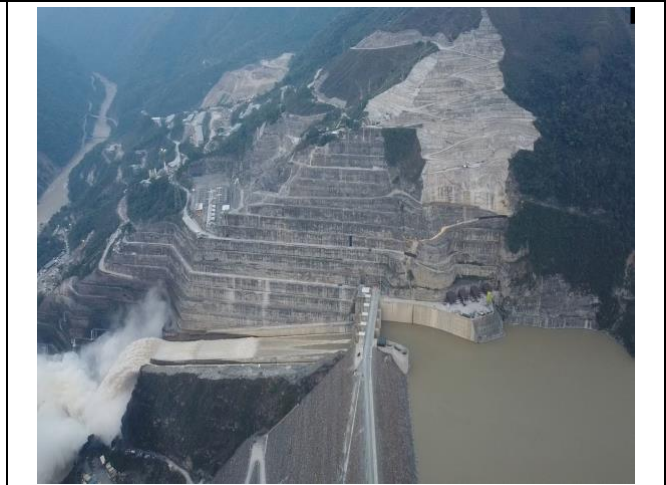
Foto 126: Vista panorámica de las principales obras del proyecto Ituango
