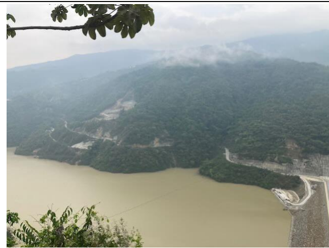
Foto 16: Zonas inestables en 0+900 (a 900 m de la presa) en la margen izquierda
