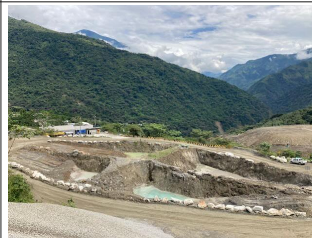
Foto 48: Disposición de residuos líquidos de trampas de sedimentos en Ticuita
