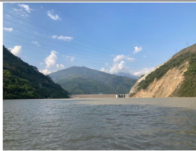
Foto 32: Vista de la presa desde el embalse
