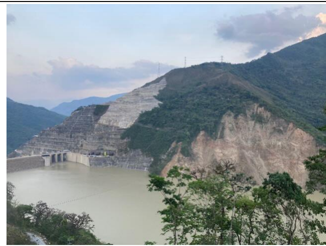
Foto 31: Presa y zonas inestables en la margen derecha
